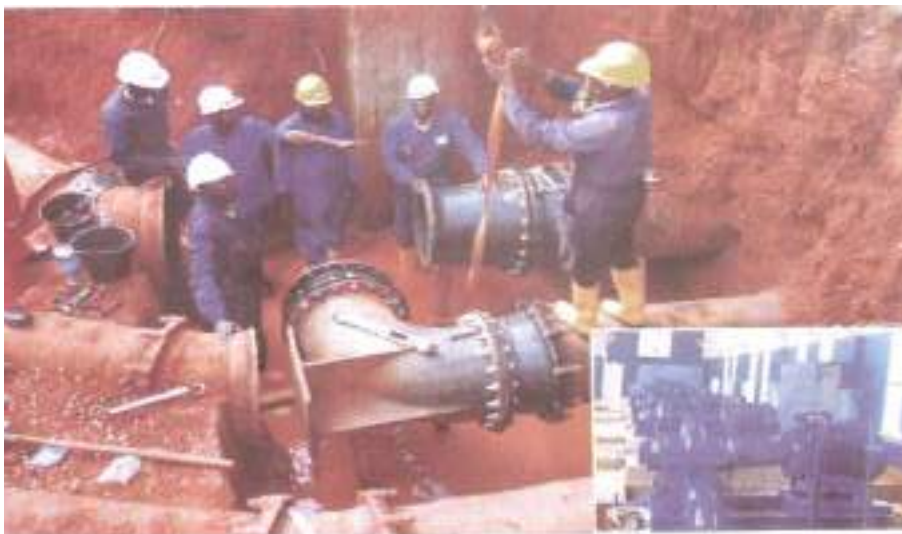
Des ouvriers sur un chantier
