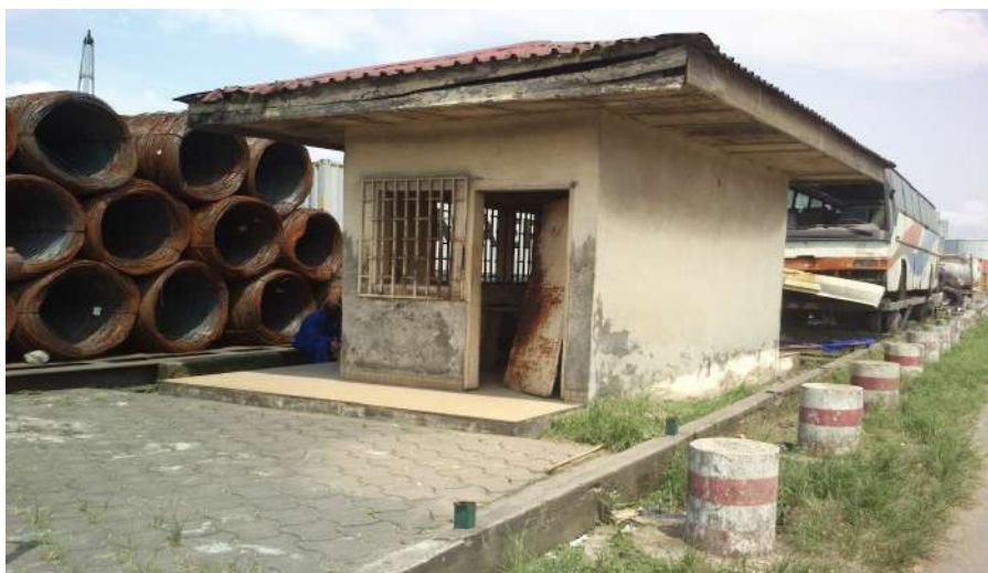
APM, Pont bascule au PAD
