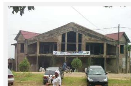
EPC bonamoussadi-Silo opérationnel
