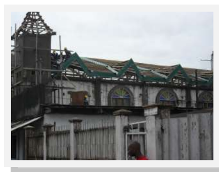
EPC Manoah en rénovation à Douala
