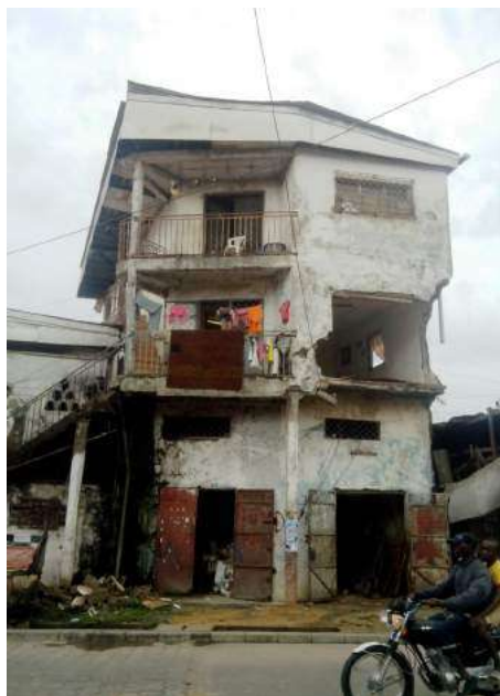
Un immeuble menaçant de s'écrouler
